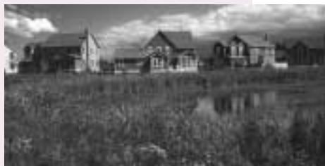
El sistema natural de drenaje pluvial de Prairie Crossing redujo los costos de infraestructura más de $ 1 millón, comparado con sistemas tradicionales.
